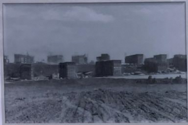
ニュータウンの造成(諏訪団地) mp004130-200020 多摩市立図書館所蔵資料、多摩市デジタルアーカイブ掲載資料
