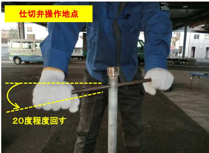
ハンドルを左にゆっくり回転させ仕切弁を開けます。仕切弁は、閉まっている状態(操作前)から約20度程度回し暫く待ちます。一気に回転させると圧縮された空気が水とともに勢いよく吹き出しがあり、非常に危険です。
