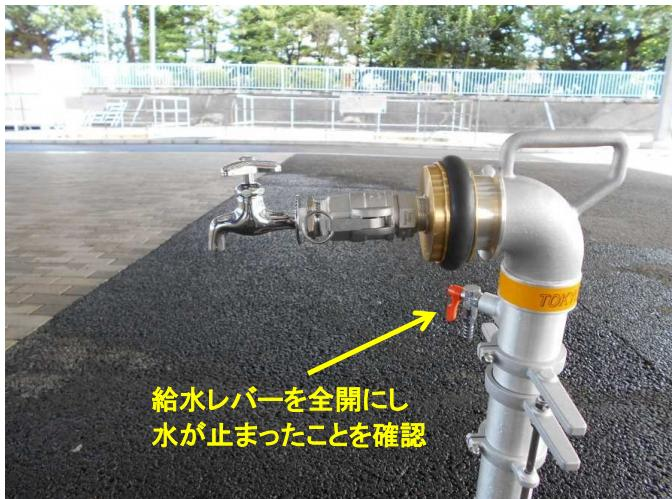
仕切弁を閉めたら、給水レバーを全開にし、水が完全に止まつたことを確認します。
