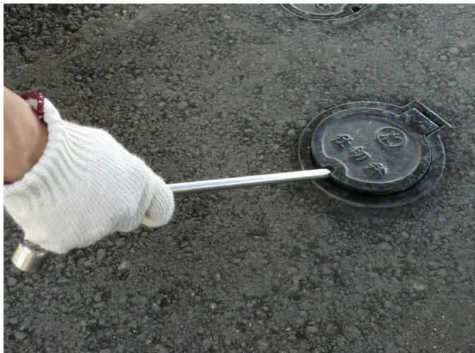
開栓器のハンドルの細い側を、仕切弁用蓋の溝に差し込み、蓋を開けます。
