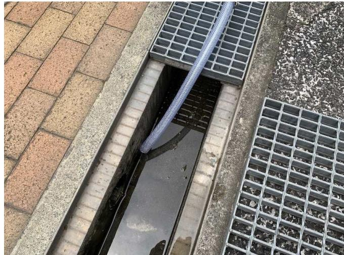
排水用ホースを、ますの中に入れた状態で、その場で待機します。蓋を開けている間は、作業者や歩行者が中に転落したり、作業に使用する資器材等が落下しないよう、十分注意して下さい。
