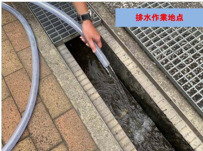
排水作業地点では、排水用ホースから空気が抜けたあと水が出てきます。空気が抜け切るまでは、ホースが激しく暴れることがあるので、しっかりとホースを持つように注意してください。
