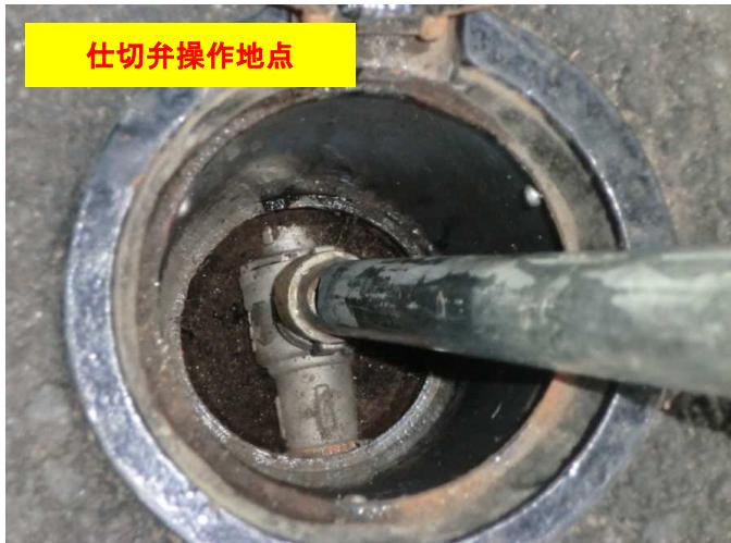
開栓器の仕切弁操作用鍵穴を、仕切弁の凸部にセットします。
