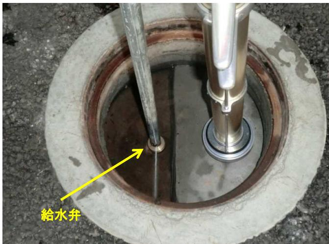
開栓器の給水弁操作用鍵穴を給水弁の凸部にセットします。
