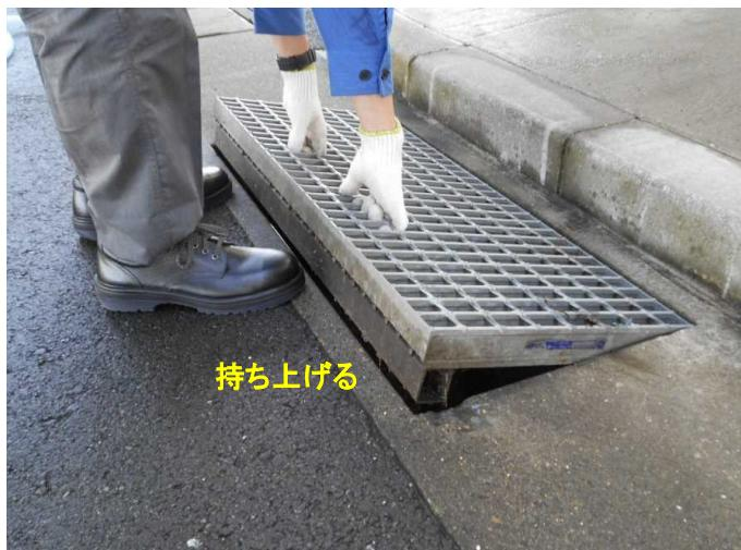
排水作業では、濁っている水をきれいになるまで吐き出すため、雨水ます等を使用して作業を行います。ますの形状や大きさ、種類には様々なものがあります。写真は、雨水用の集水ますです。ますの蓋を持ち上げ取り外します。
