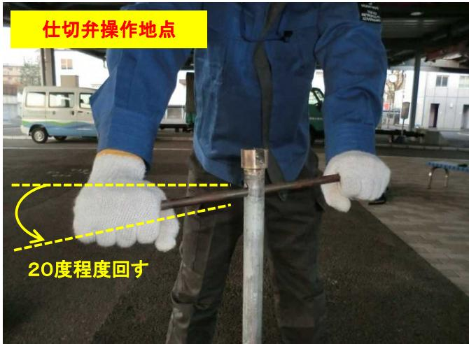
ハンドルを左にゆっくり回転させ仕切弁を開けます。仕切弁は、閉まっている状態(操作前)から約20度程度回し暫く待ちます。一気に回転させると圧縮された空気が水とともに勢いよく吹き出すことがあり、非常に危険です。
