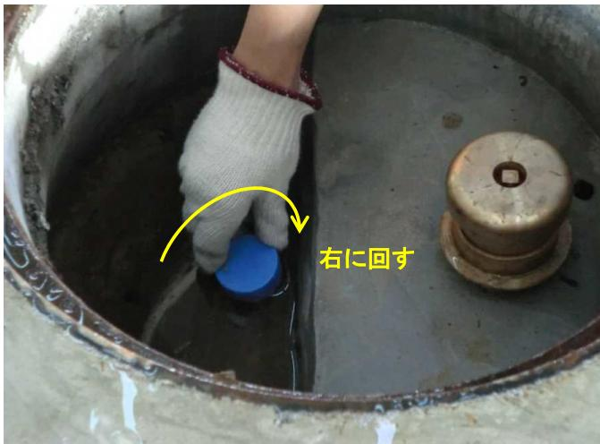
給水弁に、給水弁用キャップを取り付けて、手で右に回して閉めます。
