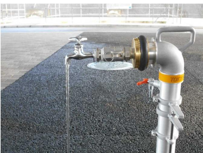
蛇口アダプターでも、蛇口を左に回し、空気を抜きます。
