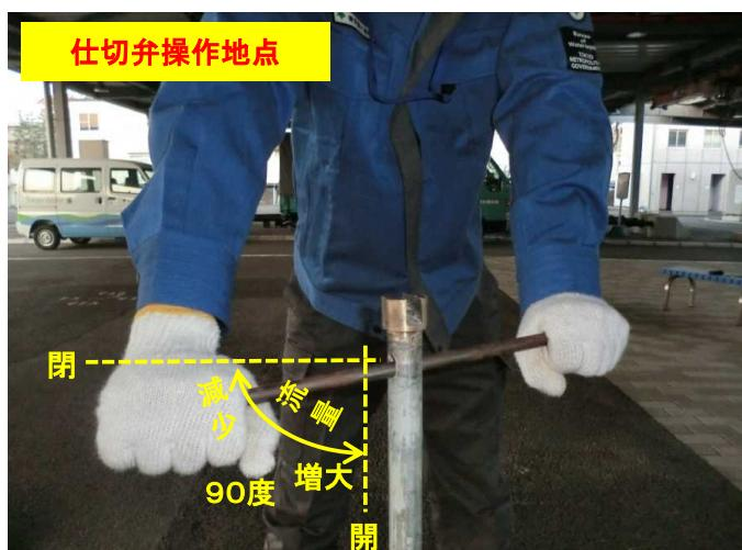
空気が完全に抜けたら、排水作業地点との合図により流量調整を行います。流量調整は、仕切弁の回転角度で調整します。仕切弁は最大90度まで回転しますが、まず等から水が溢れない程度に、流量を調整します。
