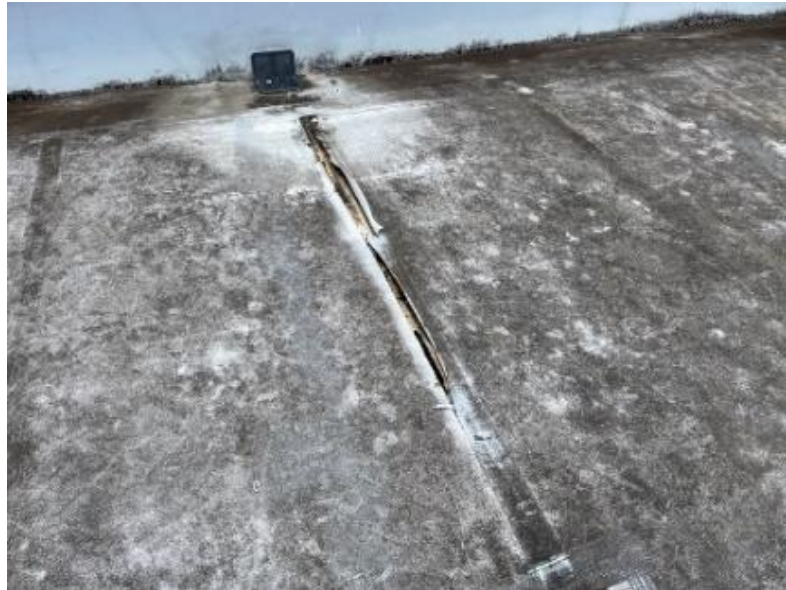
屋上防水の緩衝シート部亀裂
