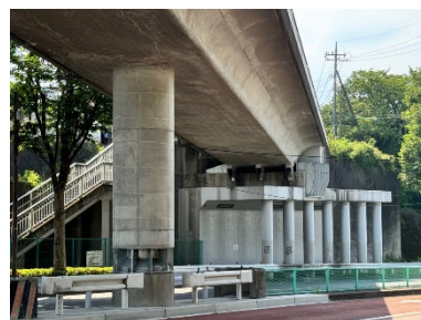
耐震補強した橋梁（桜橋）
