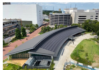
多摩市立中央図書館の屋上に設置されている太陽光パネル
