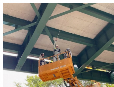
橋梁の維持管理の様子
