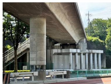
耐震補強した橋梁（桜橋）
