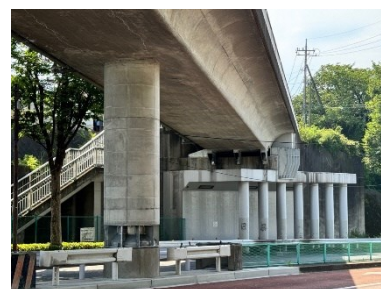
耐震補強した橋梁（桜橋）
