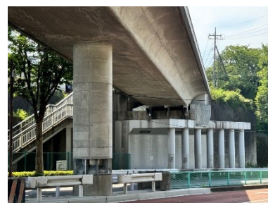
耐震補強した橋梁（桜橋）
