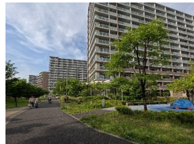
建替えられた諏訪二丁目地区
