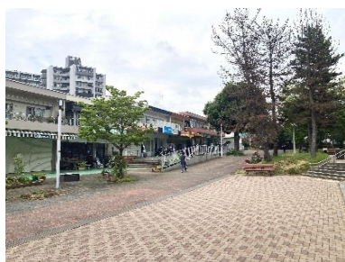
諏訪近隣センター
