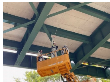
橋梁の維持管理の様子
