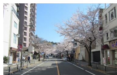
無電柱化された道路 (さくら通り)
