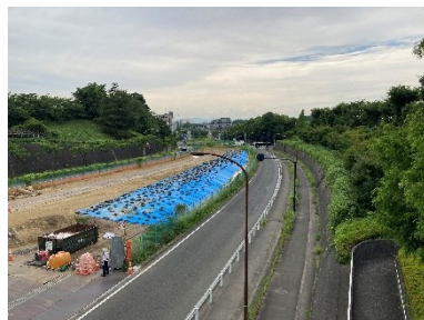
南多摩尾根幹線（Ｙ字橋から撮影）
