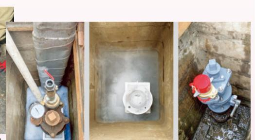
▲老朽化消火栓を局部的に凍結させて取り替え作業を行います
