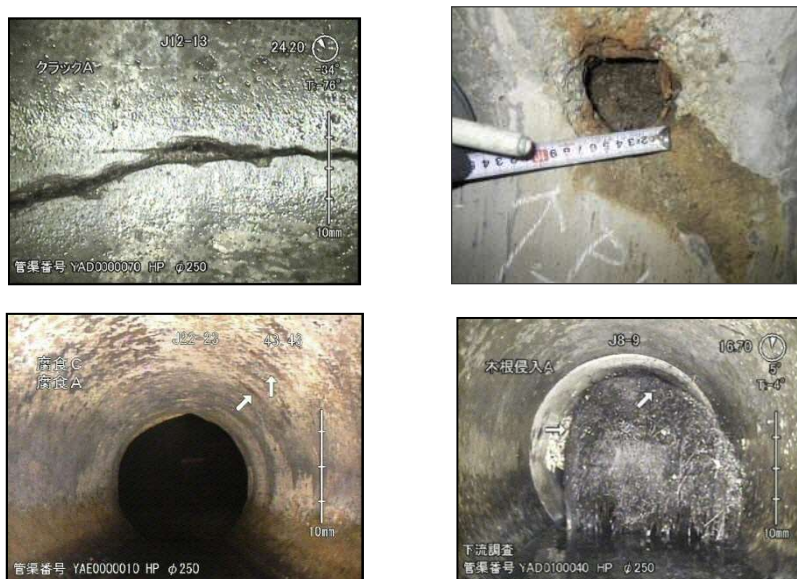
図 3.11 実際の劣化部の写真（左上：クラック、右上：破損、左下：腐食、右下：木根侵入）
