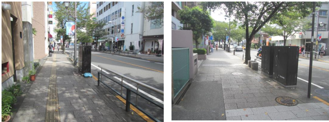
写真-5 無電柱化整備路線（市道1-1号幹線 さくら通り）
